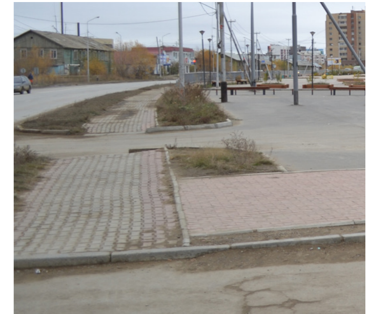
НЕУДОВЛЕТВОРИТЕЛЬНОЕ СОСТОЯНИЕ ПОКРЫТИЙ
